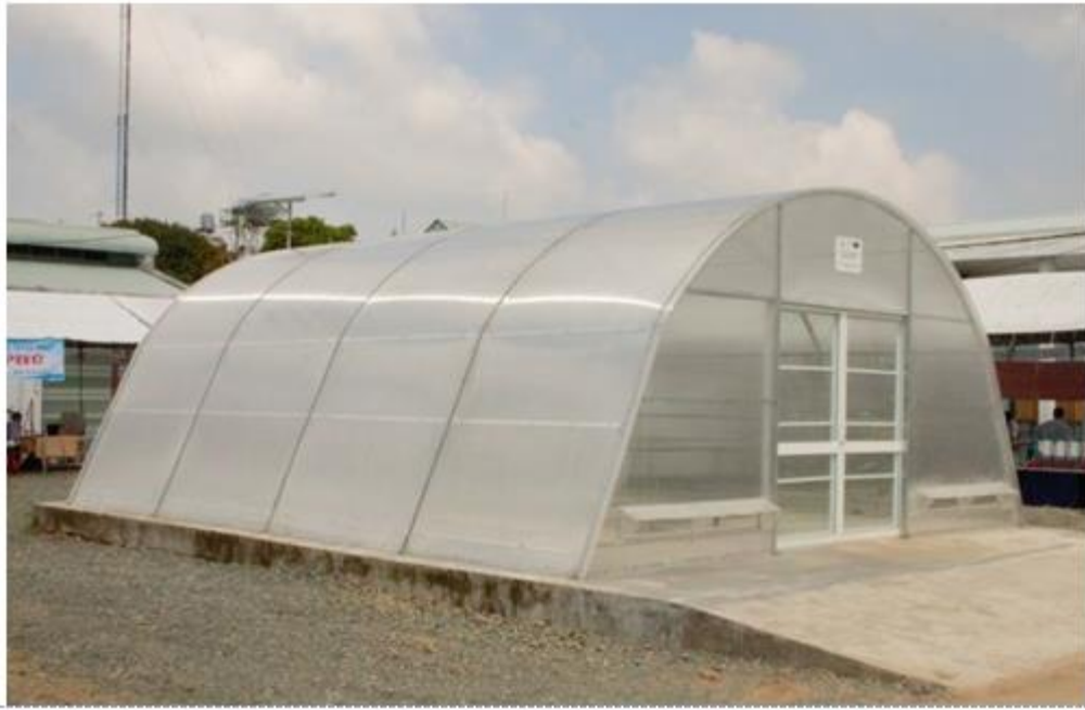
Mô hình nhà sấy kích cỡ 6m x 8m được xây dựng tại An Giang
