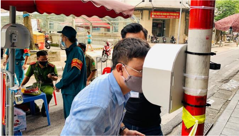
Hệ thống kiểm soát y tế thông minh CLi-SmartEyes được lắp đặt tại chợ Hàng Da (Hà Nội). Ảnh: NVCC
