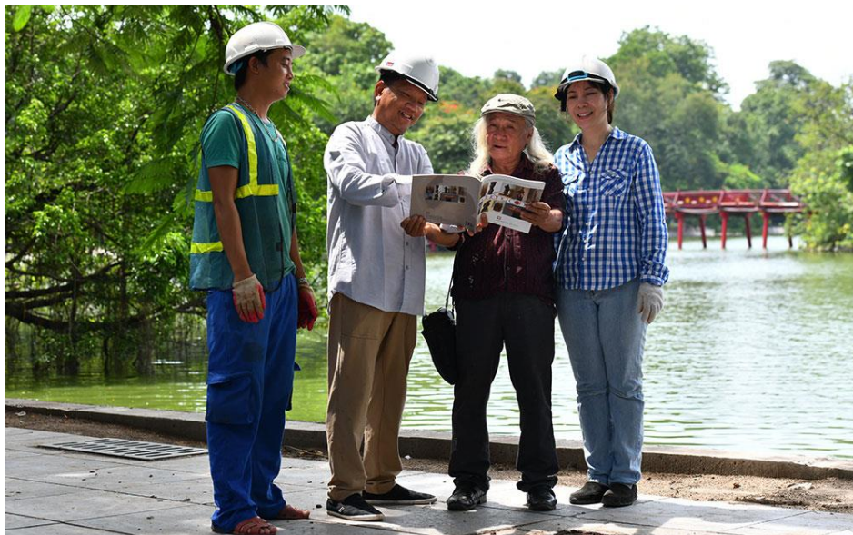
Ông Hoàng Đức Thảo và các cộng sự tại công trình thi công sửa chữa kè hồ Hoàn Kiếm.
