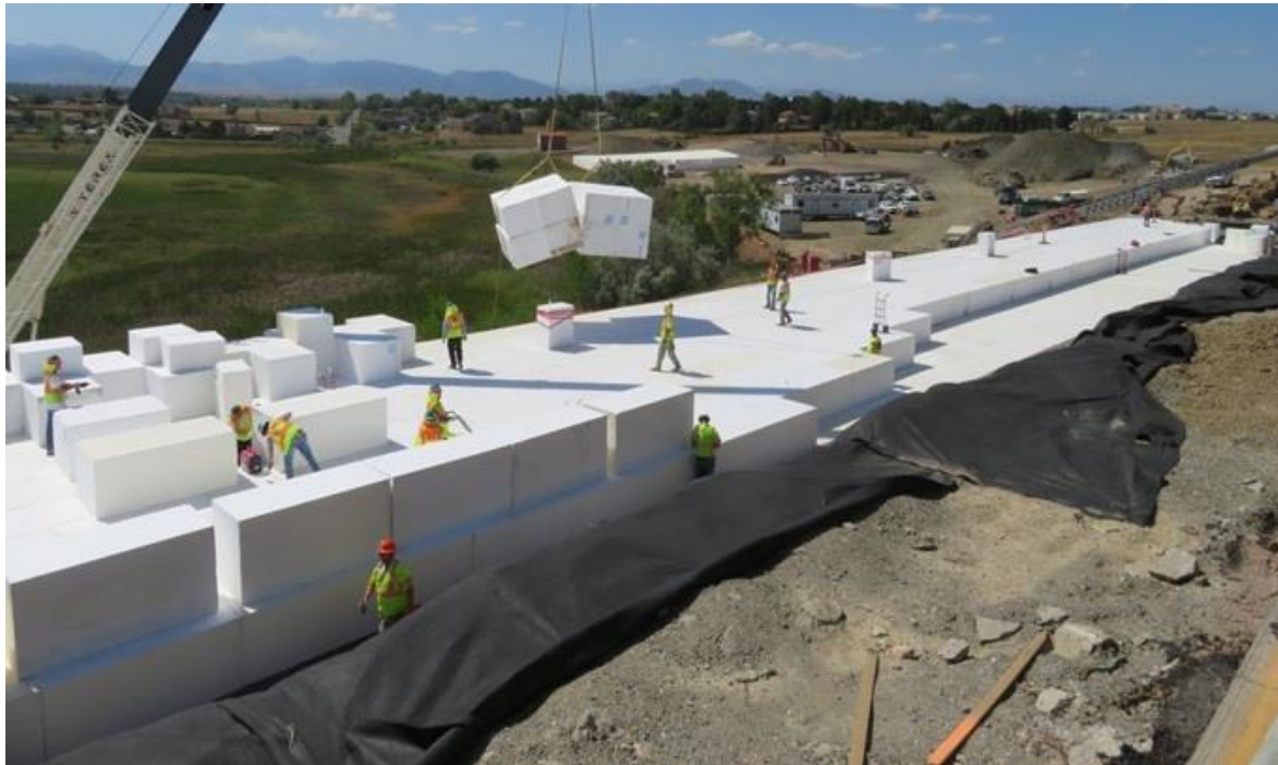
Sử dụng vật liệu nhẹ địa kỹ thuật EPS đắp nền đường thay đắp đất truyền thống [7]
