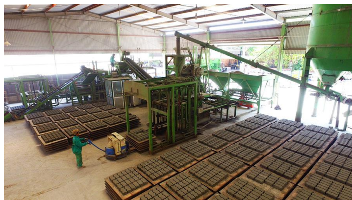
Công nhân vận thiết bị sản xuất trong ca làm việc tại doanh nghiệp KH&CN Công ty Cổ phần Cơ khí và Vật liệu xây dựng Thanh Phúc.
