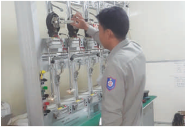
Thực hiện kiểm định công tơ điện
