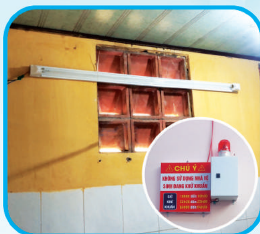
Thiết kế và lắp đặt đèn UV khử khuẩn tự động nhà vệ sinh ở khu cách ly F1 xã Phú Lâm, huyện Phú Tân
