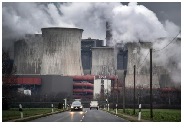
Nhà máy điện than tại Niederaussem, miền tây nước Đức
